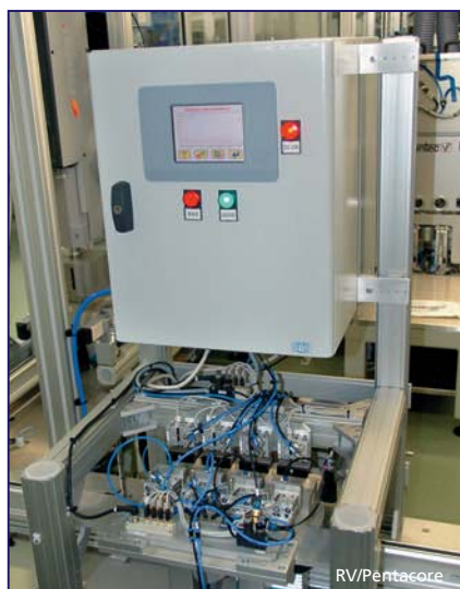
Pentacore Industries a porté son choix pour un système de détection de fuite par mesure de débit massique du fabricant SDT International.
